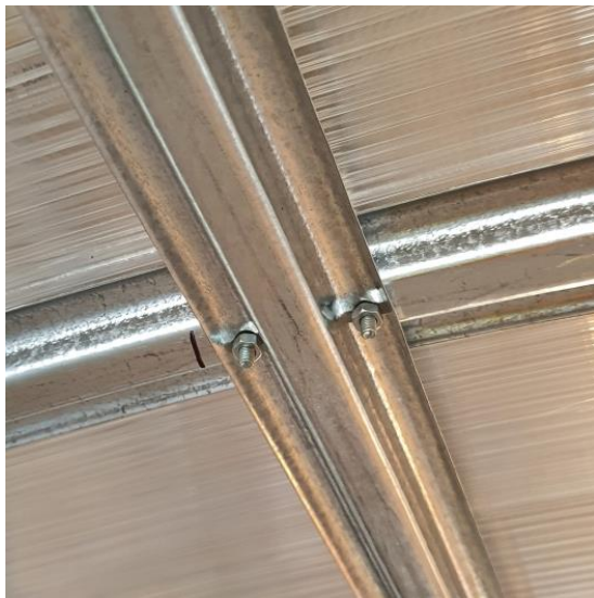
detail B (pohľad zvnútra skleníku)
